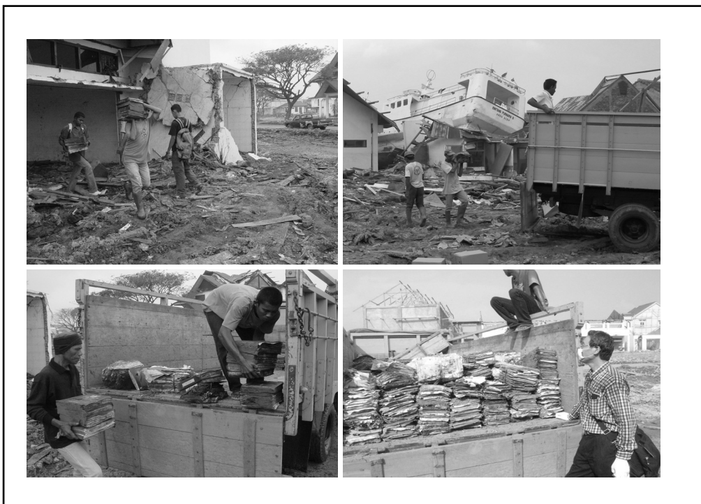
写真6 被災建物から土地台帳の救出は続く
